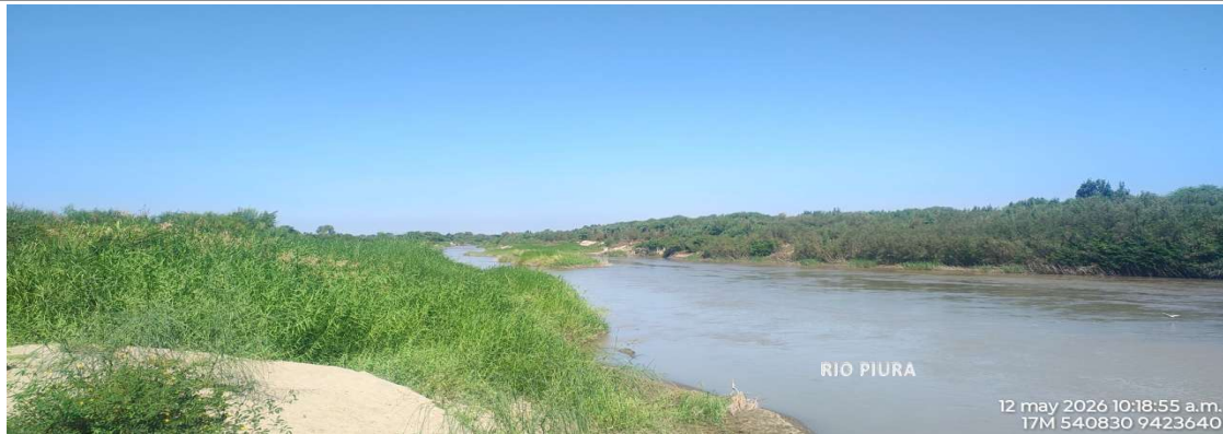
FIGURA N°01: TRAMO CRÍTICO EN EL RIO PIURA, EN SECTOR LA LEGUA PALO PARADO PAREDONES MONTE CASTILLO, DISTRITO DE CATACAOS, PROVINCIA DE PIURA - PIURA.
